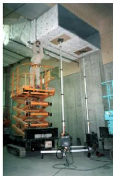
ダクト、天井作業、電気工事などなど
