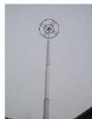
角柱9mアンテナポール
